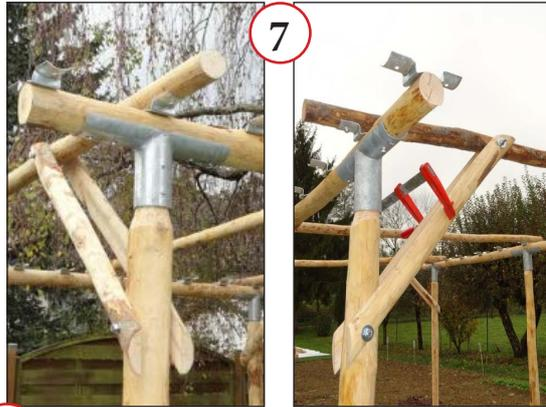
7 Die restlichen Sparren auflegen und verschrauben. Schrauben 8 x 30 mm
